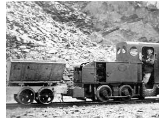
Dans la carrière, les manoeuvres des wagonnets étaient aussi assurées par des locomotives adaptées.
